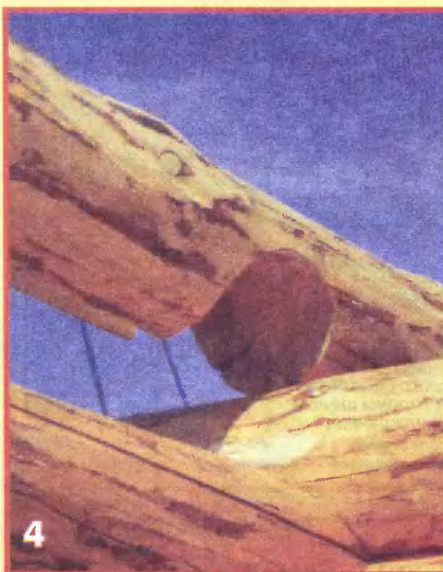
Недопустить «перебора седла»! Бревно с черновым вырезом размечают под седло (фото 3), но нижнее бревно чересчур широко для нормальной посадки седла. Техническое решение: чертилку переворачивают и обводят на нижнем бревне участок, в пределах которого нужно стесать «щеку» бревна (фото 4). Если торцы бревен будут открыты взгляду, их доводят долотом (фото 5).
