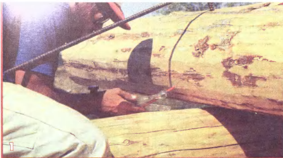
Разметка. Плотник с помощью самодельной чертилки размечает на новом бревне седловый вырез (фото 1). Новое бревно зафиксировано на нижнем скобой из арматурного прута. Затем бревно откатывают назад и плотник режет «седло» вчерне (фото 2) цепной пилой с широким ба-ром. Такой вырез опустит бревно примерно на 5–7,5 см, что позволит произвести окончательную разметку по всей его длине.
