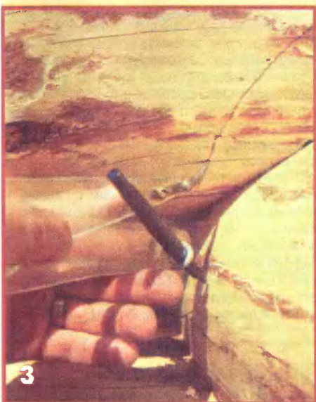
Недопустить «перебора седла»! Бревно с черновым вырезом размечают под седло (фото 3), но нижнее бревно чересчур широко для нормальной посадки седла. Техническое решение: чертилку переворачивают и обводят на нижнем бревне участок, в пределах которого нужно стесать «щеку» бревна (фото 4). Если торцы бревен будут открыты взгляду, их доводят долотом (фото 5).
