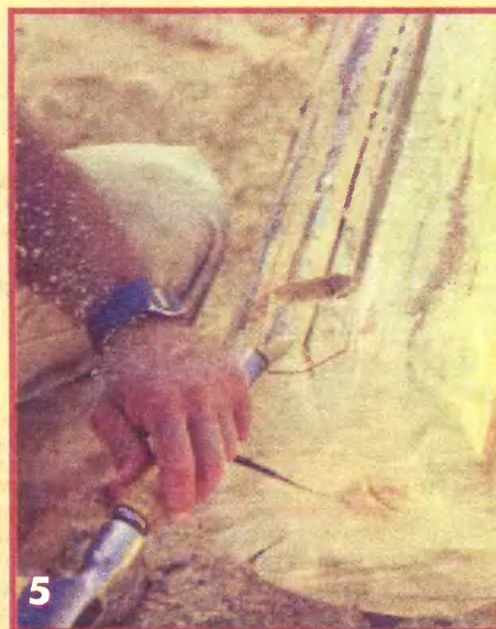
Недопустить «перебора седла»! Бревно с черновым вырезом размечают под седло (фото 3), но нижнее бревно чересчур широко для нормальной посадки седла. Техническое решение: чертилку переворачивают и обводят на нижнем бревне участок, в пределах которого нужно стесать «щеку» бревна (фото 4). Если торцы бревен будут открыты взгляду, их доводят долотом (фото 5).
